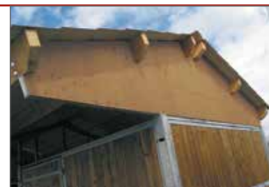
Habillage sous toiture des pignons
