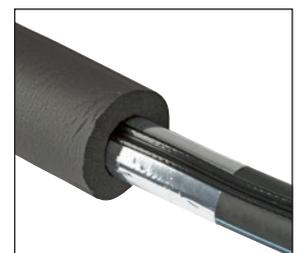
Prima del montaggio dei cavi riscaldanti avvolgere i tubi dell'acqua in plastica con nastro adesivo in alluminio
